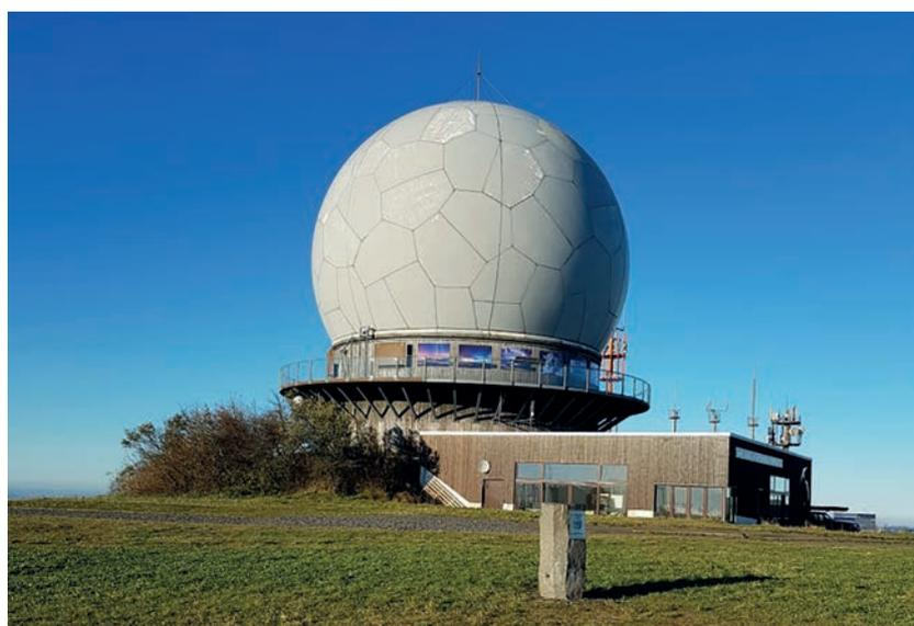
Abb. 16: Das Radom mit Aussichtsgalerie und Blitzableiter auf der Kuppel. Im Vordergrund die Basalt-Stele „Höchster Punkt des Landkreises Fulda“.
