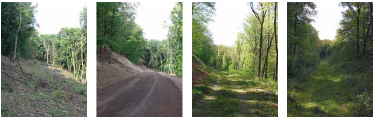
Abb. 4: Waldwegbau (v.l.n.r): Trassenaufrieb, Wegebau mit LKW-befahrbarer wassergebundener Decke (Zustand 2013), durch natürliche Sukzession begrünter und schließlich vollständig eingewachsener Waldweg im Jahr 2018 (Fotos: Sebastian Turck, Dienstleistungszentrum Ländlicher Raum (DLR) Westerwald-Osteifel)
