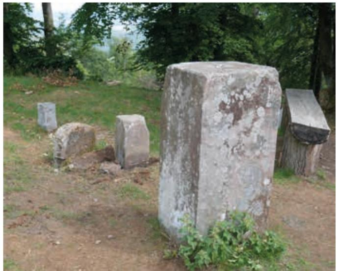
Abb. 9 und 10: Die vier historischen Vermessungs- und Grenzmale auf dem Hasserod (Reihenfolge im linken Bild von vorn nach hinten, im rechten Bild von links nach rechts): TP-Granitpfeiler 3. Ordnung von 1903, Grenzstein von 1829, hessischer DH-Pfeiler II. Ranges von 1829 und der große Gradmessungspfeiler von 1868.
