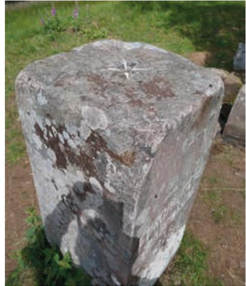
Abb. 7 und 8: Der Gradmessungspfeiler auf dem Hasserod mit der Inschrift „EUROPÄISCHE GRADMESSUNG 1868“ auf der Südseite. Das Zentrum ist in der Kopffläche durch ein Loch markiert (Mitte des Kreidekreuzes).
