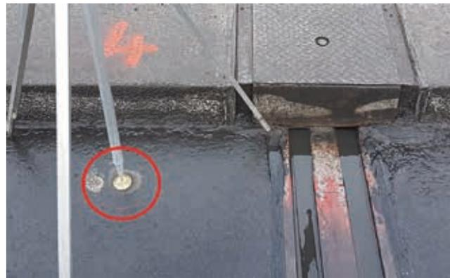
Abb. 4: Höhenbolzen 4 (RFP-Kopf) auf der Brücke (Foto: HLBG)
