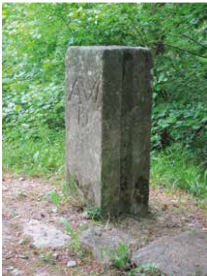
Abb. 4 und 5: Die beiden kurhessischen Festlegungen auf der Boyneburg von 1845 – links der Postamentstein Boyneburg-Nord mit Rille, rechts der Markierungsstein Boyneburg-Süd mit Kreuzschnitt.
