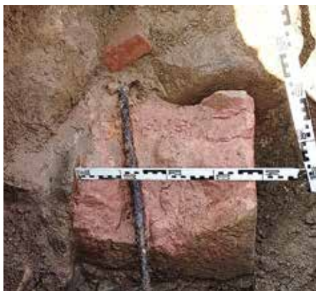
Abb. 18 und 19: Der vorgefundene Pfeilerrest des Basisanfangspunktes A mit umgebenden Fundamentsteinen. Die Steinmitte (rechtes Bild) wurde anhand der 4 Eckpunkte bestmöglich rekonstruiert.
