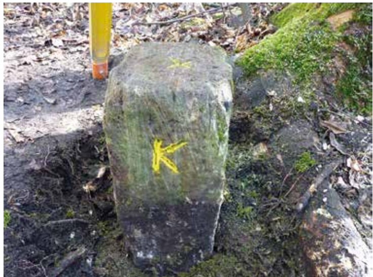
Abb. 4 und 5: Die beiden kurhessischen Festlegungen auf der Boyneburg von 1845 – links der Postamentstein Boyneburg-Nord mit Rille, rechts der Markierungsstein Boyneburg-Süd mit Kreuzschnitt.
