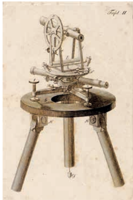
Abb. 10 und 11: Repetitionstheodolit von Rößler (aus [1] Eckhardt 1813 Tafeln I und II)
