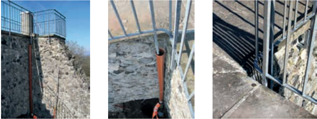
Abb. 27 bis 29: Örtliche Rekonstruktion der Lage der Signalstange von 1823 mittels PVC-Rohr
