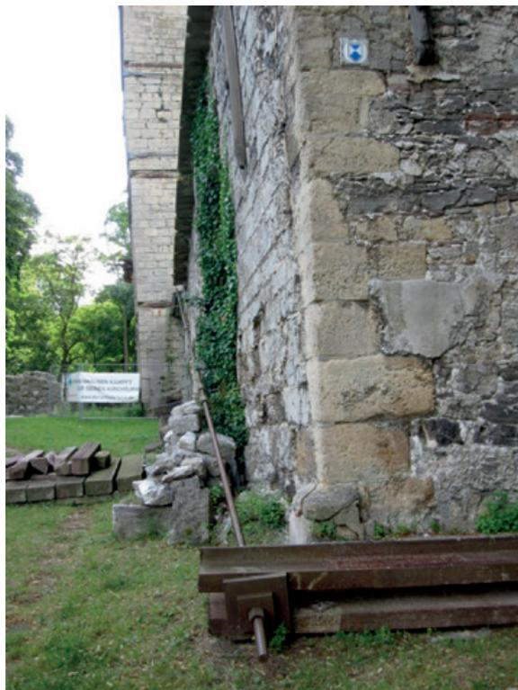
Bild 2: Mit schweren Ankern wird versucht, weitere Bewegungen des Mauerwerks zu verhindern
