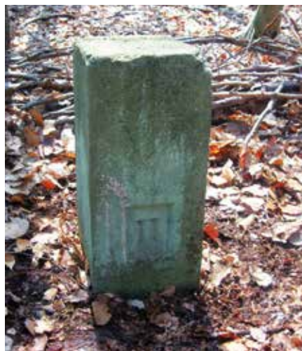
Abb. 19 bis 21: Nassauische Vermarkung II. Ordnung (Fotos: Dreieckspunkt „Unnerkuppel“)
