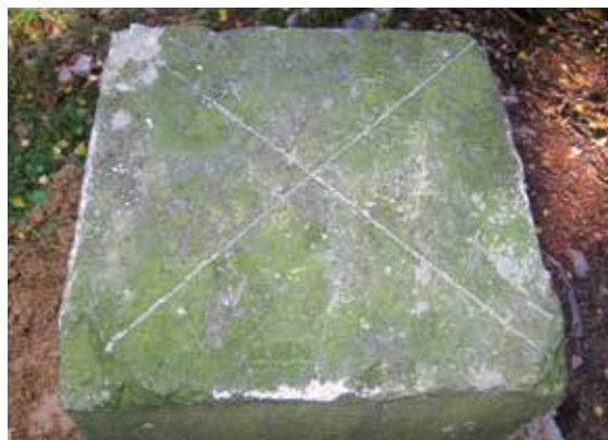
Abb. 15: Kreuzschnitt auf Kopffläche
