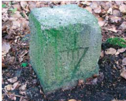
Abb. 22 bis 24: Nassauische Vermarkung III. Ordnung
