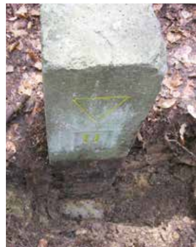
Abb. 19 bis 21: Nassauische Vermarkung II. Ordnung (Fotos: Dreieckspunkt „Unnerkuppel“)
