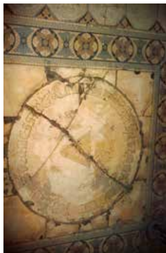
Abb. 5 und 6: Steinplatte im Schloss Schaumburg zur Kennzeichnung des Nullpunktes der Nassauischen Landes-triangulation (Fotos: Ewald Ehrmantraut und LVermGeo Rheinland-Pfalz)
