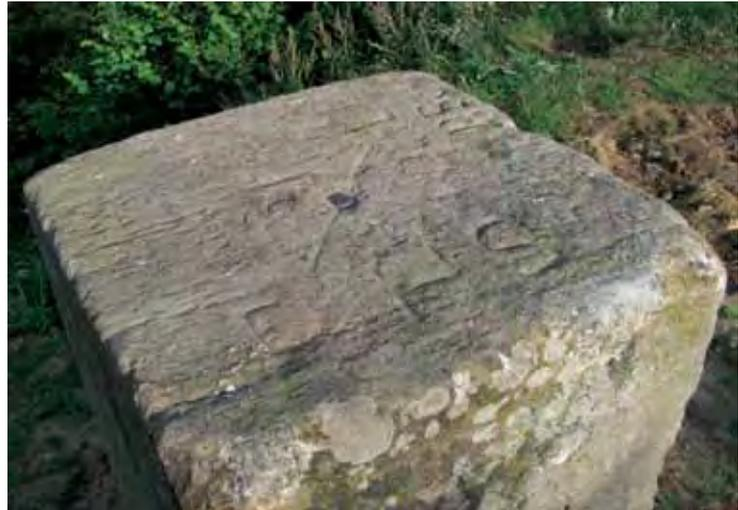
Abb. 7: Kreuzschnitt auf der Kopffläche des Frauenberger Steinpfeilers mit später eingelassenem Leuchtbolzen
