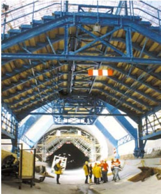
Bild 2: Schalungen für den Tunnelausbau
