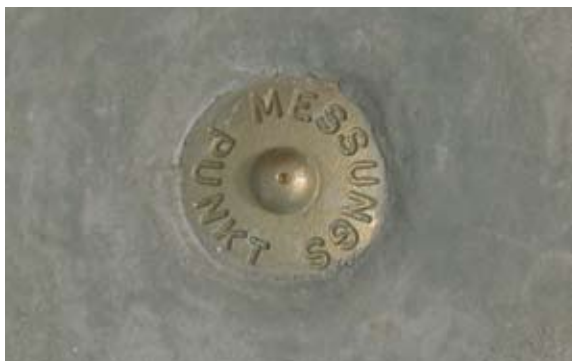
Abb. 18: Messingmarke auf Betonweg
