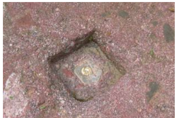
Abb. 16: Messingmarke in Steinpfeiler G
