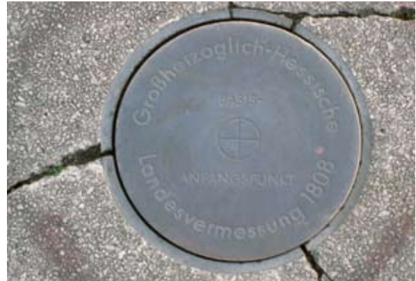
Abb. 14: Markierung des hergestellten Punktes A
