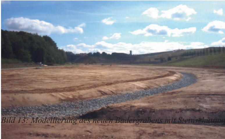
Bild 13: Modellierung des neuen Badergrabens mit Steinschüttung
