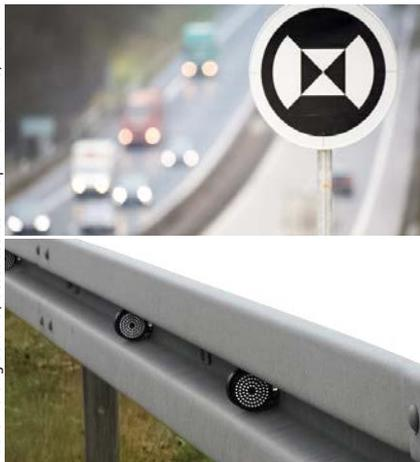
Schild zur Eigenlokalisierung (oben) und Radarreflektoren in Leitplanke (unten)
