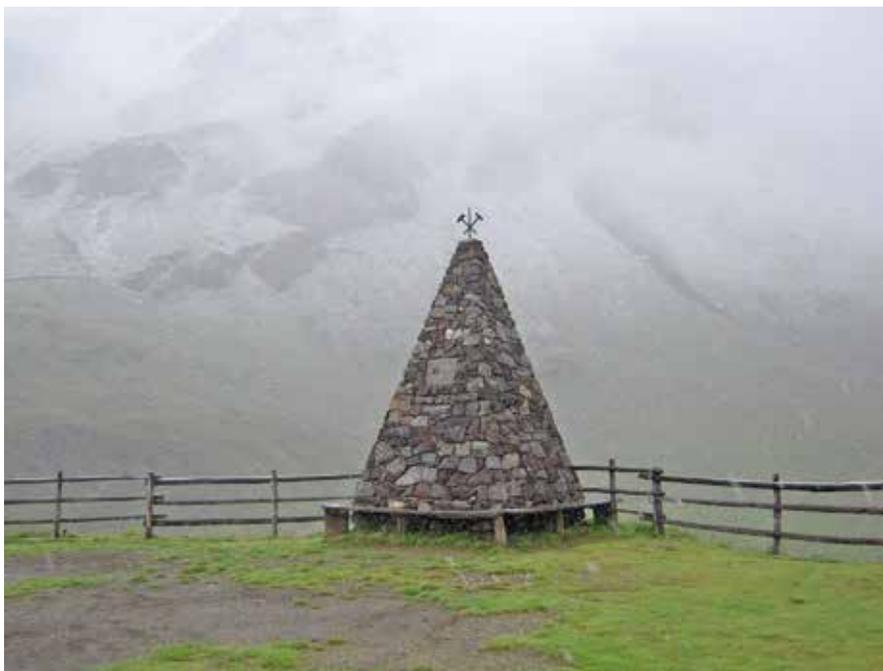
*Markierung des Nullpunkts des Schneeberger Koordinatensystems zur Vermessung des Bergwerks am Schneeberg im 19. und 20. Jh., gleichzeitig Punkt 8 des Triangulationsnetzes*
